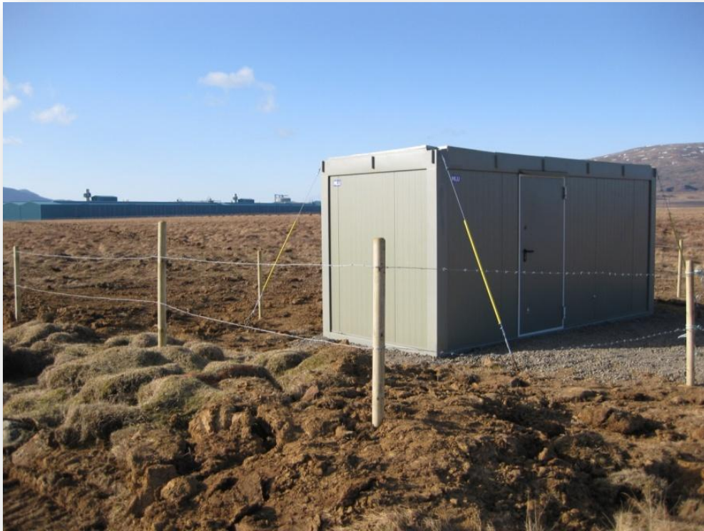
Mynd 1. Loftgæða og veðurmælingahús við Kríuvörðu.
